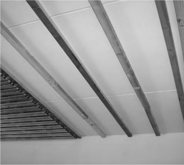
Bei einer direkt verschraubten Unterkonstruktion sind die Zwischenräume bauseitig zu dämmen.
