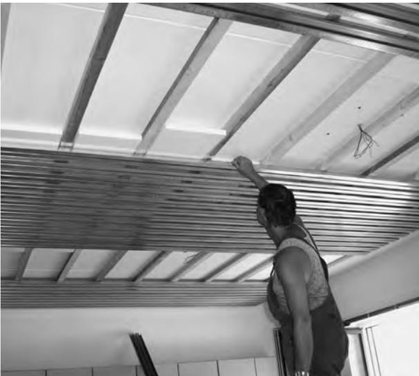
Bei einer abgehängten Unterkonstruktion müssen die separat erhältlichen Kreuzverbinder für das Klima Profil verwendet werden.
