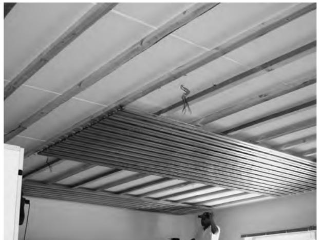
Bei einer abgehängten Unterkonstruktion müssen die separat erhältlichen Kreuzverbinder für das Klima Profil verwendet werden.
