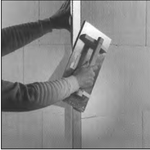
Zuschleifen der Ecken und Kanten, Anschlaglatte benutzen.
