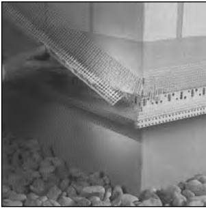
Detail: offenes Systemende im Sockelbereich. Setzen eines Gewebewinkels.
