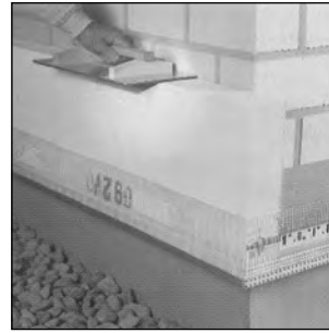
Durchschleifen der ersten Plattenreihe zur „Flucht“.
