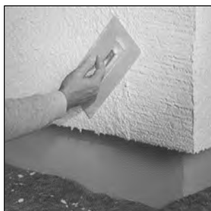
Strukturieren des Deckputzes.
