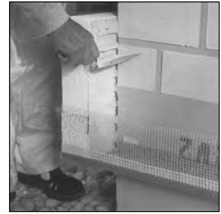
Überstehenden Kleber im Plattenstoß entfernen.
