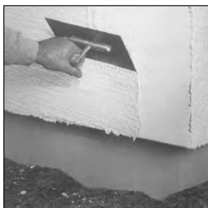
Aufziehen des Deckputzes.
