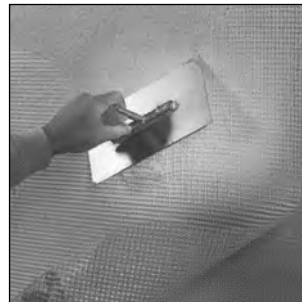
Nach dem Verkleben der Dämmplatten wird das Dennert-Armierungsgewebe an der Dämmplattenstirnseite und auf der Dämmplattenfläche in den Armierungsmörtel eingebettet. Anschließend wird das System verputzt.
