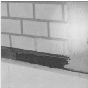
Am offenen Systemende wird ca. 20 cm breit Klebemörtel auf den Untergrund vorgelegt, in den das Dennert-Armierungsgewebe eingebettet wird. Zum freien Rand steht das Gewebe um weitere 20 cm plus der Dämmplattendicke über.
