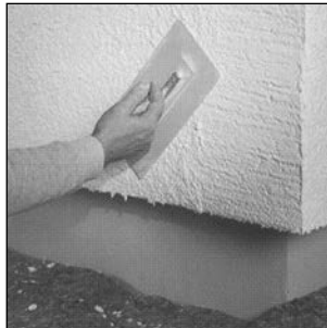
Strukturieren des Deckputzes.
