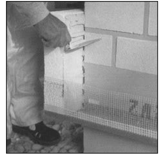
Überstehenden Kleber im Plattenstoß entfernen.
