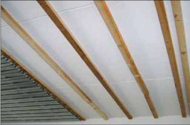
Bei einer direkt verschraubten Unterkonstruktion sind die Zwischenräume bauseitig zu dämmen.
