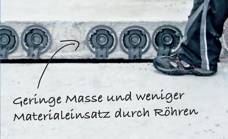
Geringe Masse und weniger Materialeinsatz durch Röhren
